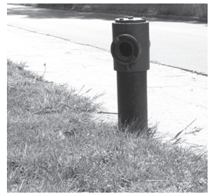
W Konarzewie wymieniono dwa hydranty przy blokach mieszkalnych.
